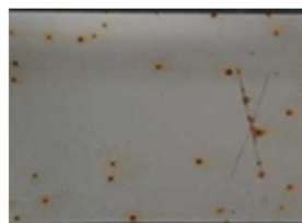
一般変性エポキシ樹脂塗料下塗
