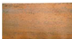
塗装前の鋼材の状態
