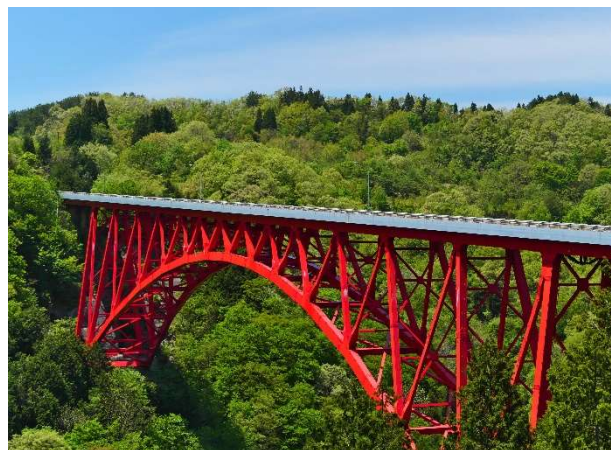
島根県 三井野大橋(国道314号)
