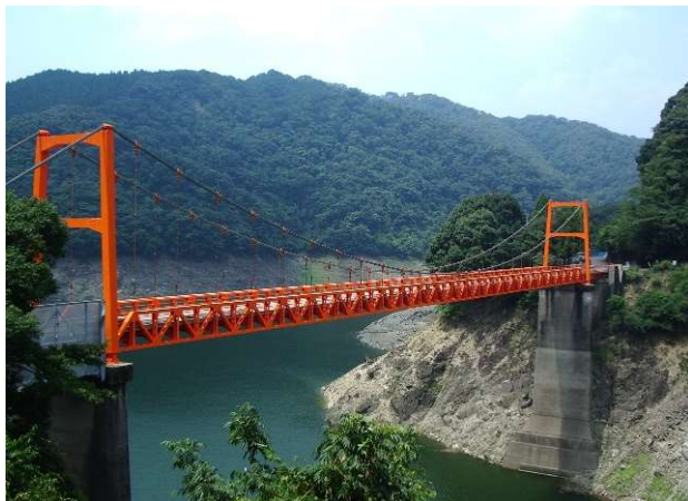
鹿児島県 石倉橋
